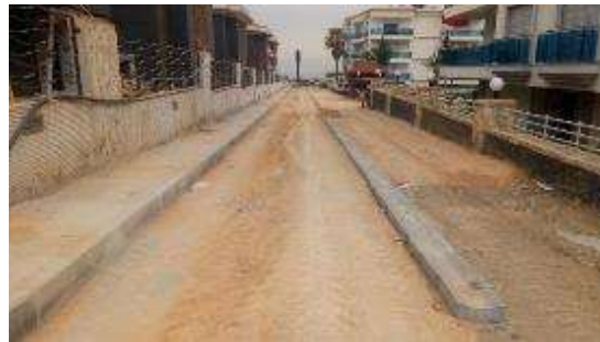
Maltepe Mahallesi 10 Sokak Yol Yapım Çalışması
