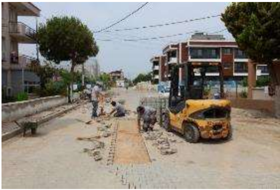
Yalı Mahallesi 59 Sokak Doğalgaz Tamirat Çalışması
