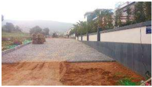
Yelki Mahallesi 2129 Sokak Yol Yapım Çalıřması
