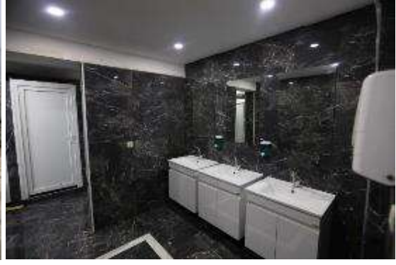
1. Liman Wc Yapımı
