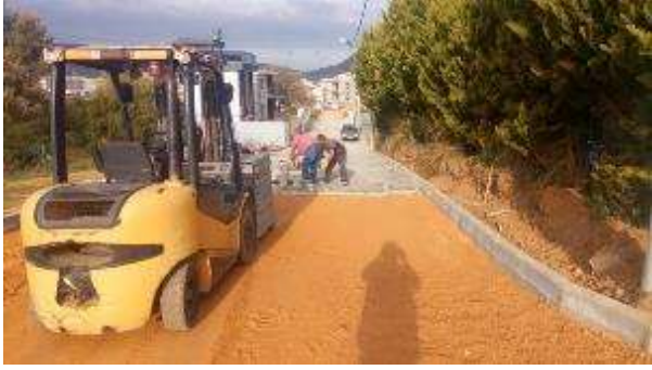
Yelki Mahallesi 2121 Sokak Yol Yapım Çalıřması
