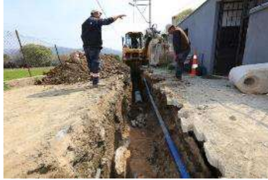
Çamlı Mahallesi Kanalizasyon Hattı Döşenmesi
