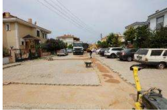
Yalı Mahallesi 83 Sokak Doğalgaz Tamirat Çalışması
