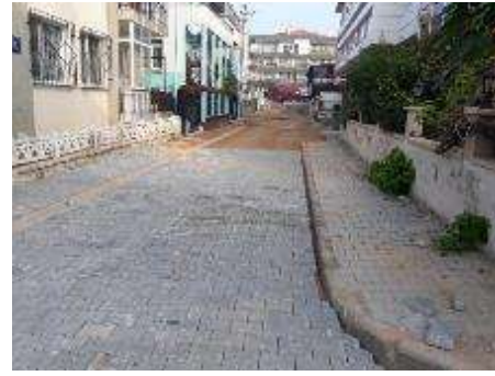
Yalı Mahallesi 218 Sokak Yol Yapım Çalışması
