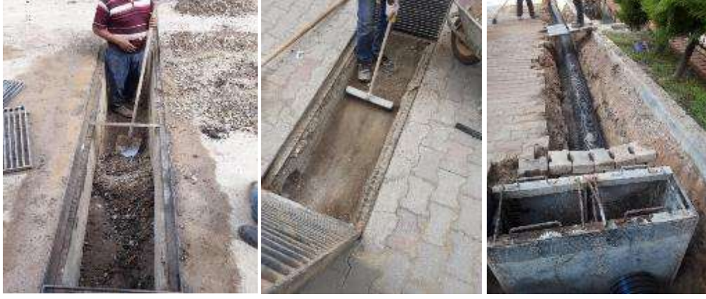
Mazgal Tamiratları, Borulama ve Temizlik Çalışmaları
