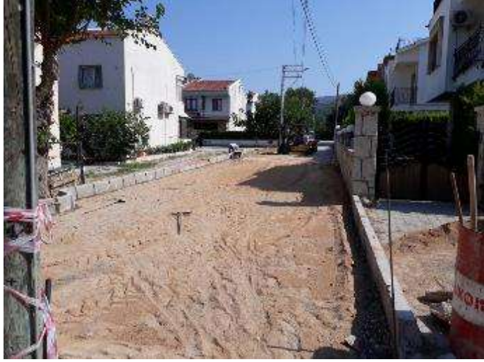
Yalı Mahallesi 148 Sokak Yol Yapım Çalıřması
