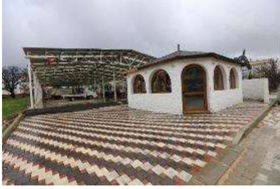
Yelki Mahallesi Pazar Yeri Çay Ocağı Tadilatı
