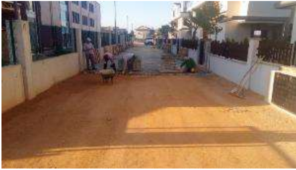
Kahramandere Mahallesi 836 Sokak Yol Yapım Çalışması
