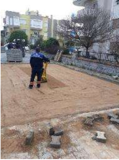
Yalı Mahallesi 127 Sokak Yol Tamirâtı
