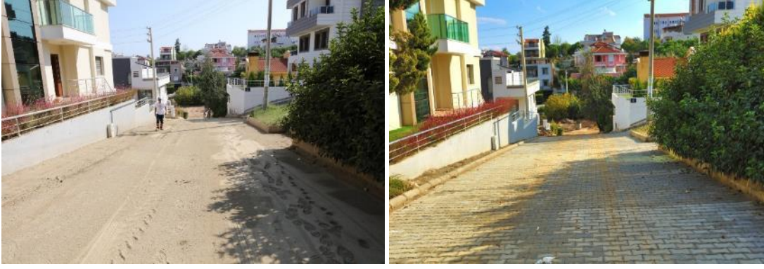
Çelebi Mahallesi 289 Sokak Yol Yapım Çalışması
