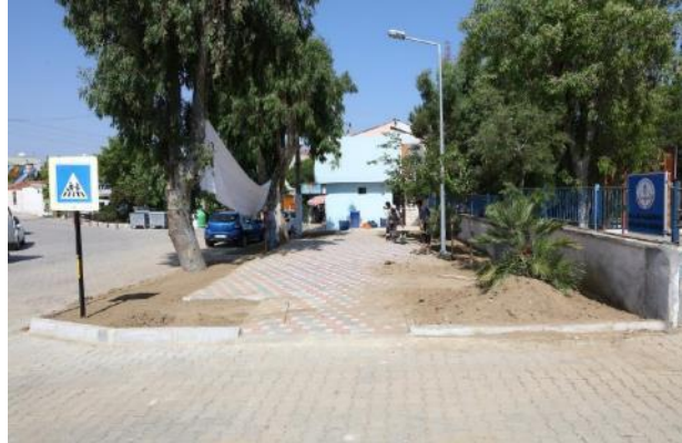
Atatürk Mahallesi Vali Kazım Paşa Okulu Önü Düzenleme Çalışması
