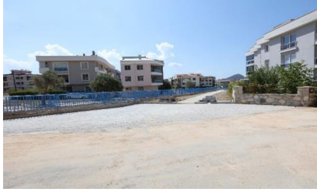
Yelki Mahallesi 2330 Sokak Yol Yapım Çalışması
