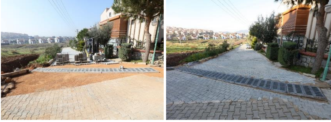
Kahramandere Mahallesi 677 Sokak Yol Yapım Çalışması
